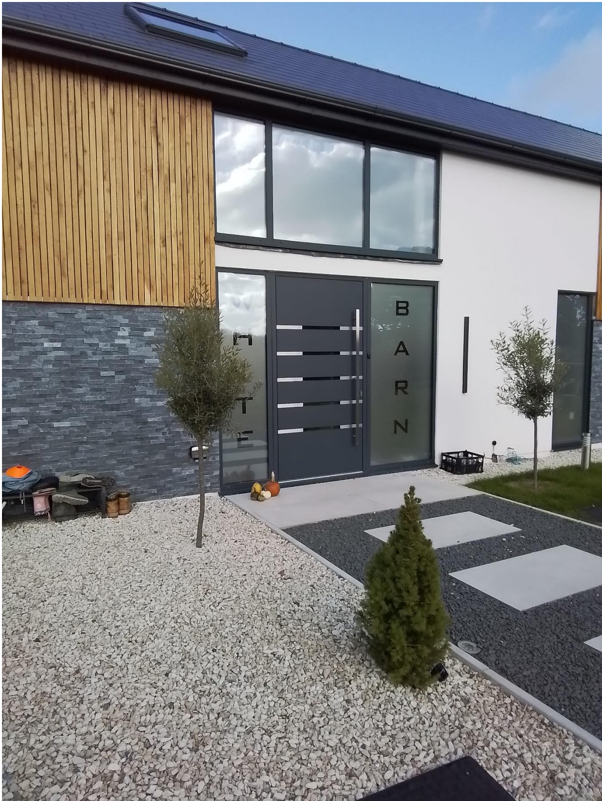
Front Door White Barn
